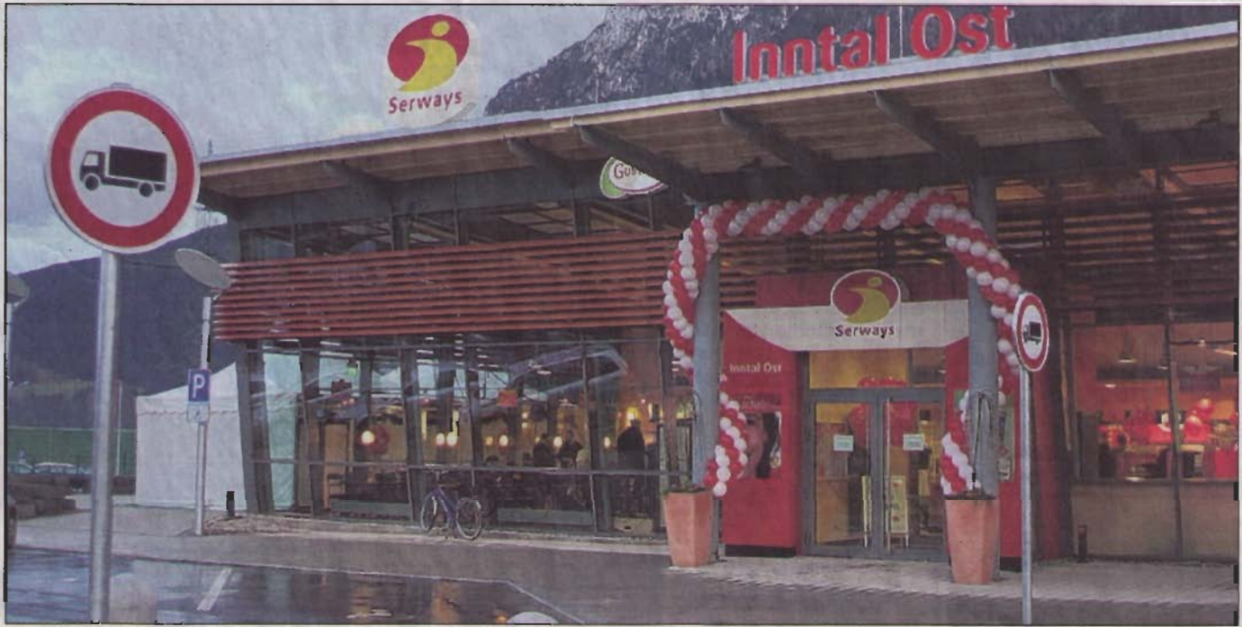
Inntal-Ost: Mit einem modernen Konzept, das europäische Normen setzen soll, wartet die neu eröffnete Tank- und Rastanlage Inntal-Ost auf. Zudem stehen 80 Pkw- und 75 Lkw-/Busparkplätze bereit.
